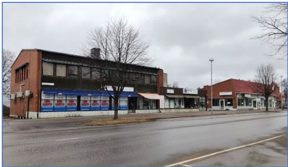
Kuva 12. Keskuskorttelin Oulaistenkadun varren rakennuksia.
