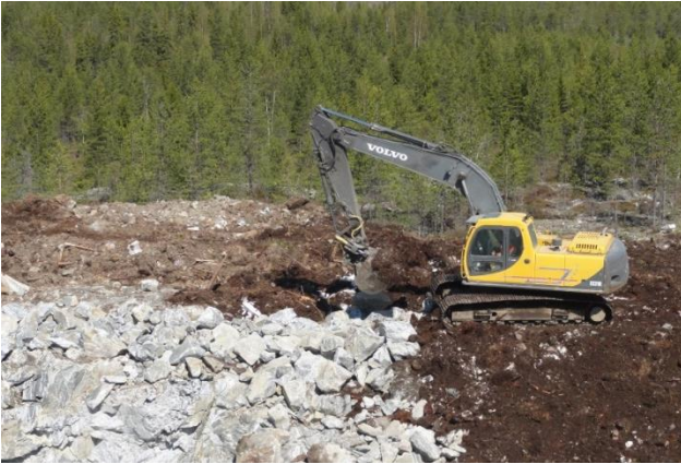
Kuvapari 2.16. Tuulivoimapuiston rakentaminen alkaa huoltoteiden ja pystytysalueiden rakentamisella (kuvat: Ville Suorsa, FCG).
