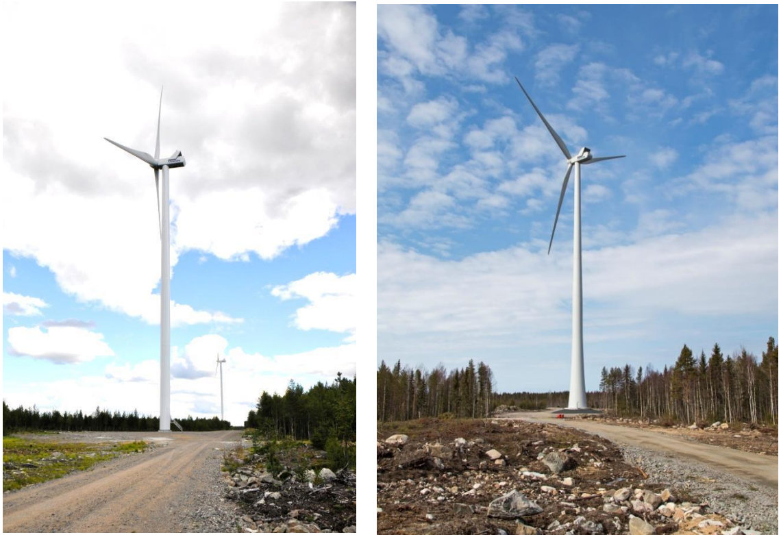
Kuva 2.10. Vasemmalla on esimerkki teräslieriötornista ja oikealla hybriditornista. (Kuvat: Leila Väyrynen ja Ville Suorsa, FCG)
