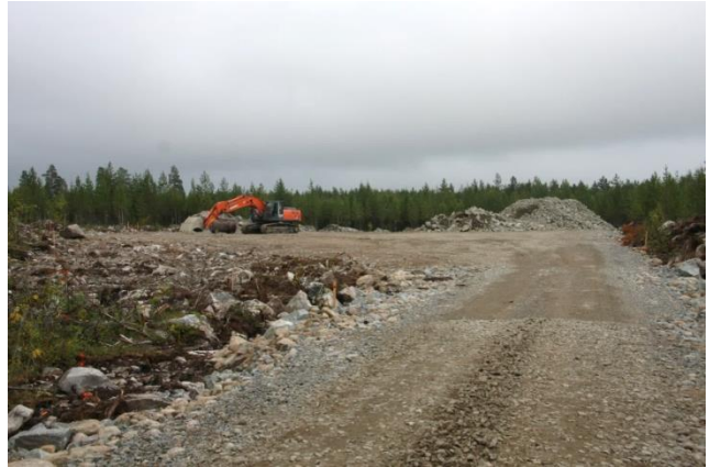
Kuvapari 2.16. Tuulivoimapuiston rakentaminen alkaa huoltoteiden ja pystytysalueiden rakentamisella (kuvat: Ville Suorsa, FCG).
