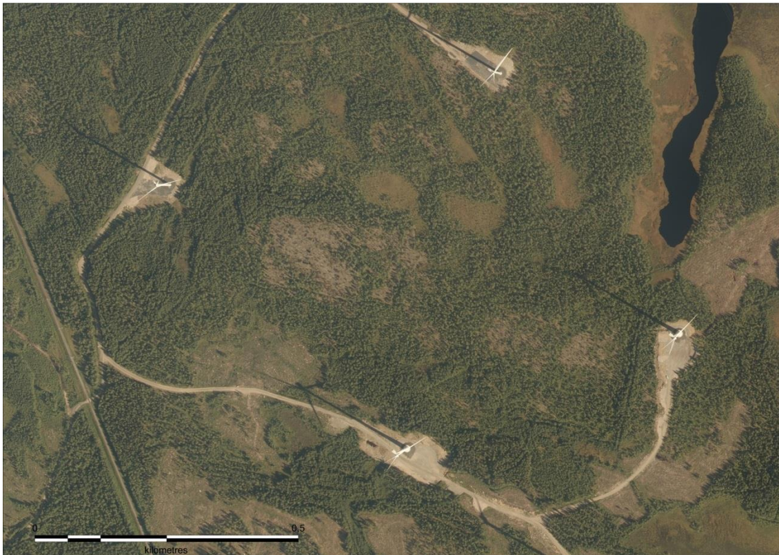
Kuva 2.9. Ilmakuvassa näkyy toiminnassa olevia tuulivoimaloita. Tuulivoimaloita varten on rakennettu huoltotiet ja nostokentät. Tuulivoimaloiden ympäristössä ja välialueilla aikaisempi maankäyttö on säilynyt ennallaan.
