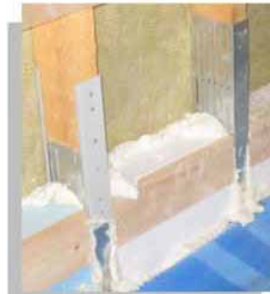
Valesokkeli korjattu termotuotteilla
